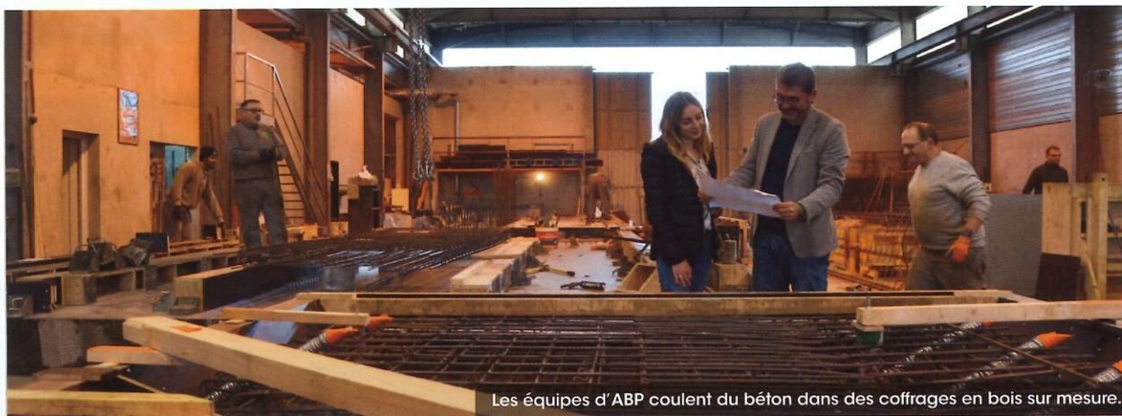
Les équipes d'ABP coulent du béton dans des coffrages en bois sur mesure.
