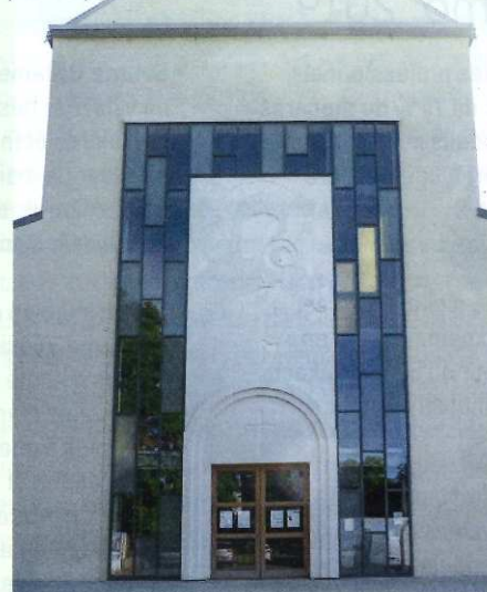
Cibetec a produit deux panneaux en béton de poudre de Carrare poli.
